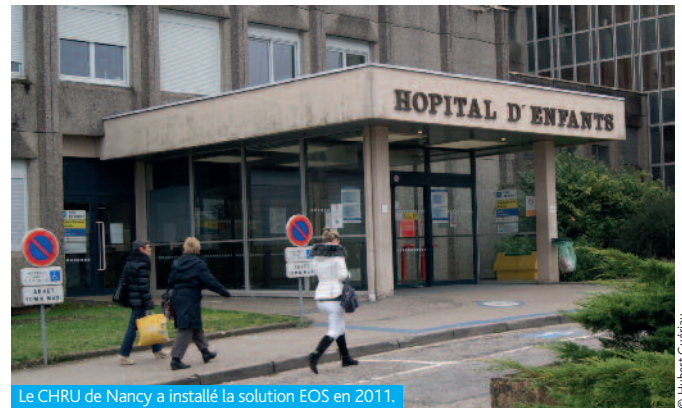
Le CHRU de Nancy a installé la solution EOS en 2011.
